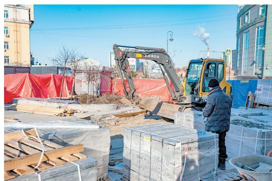
«Уже на 80 % готово бетонное основание для мощения тротуарной плиткой, идет укладка брусчатки. Сейчас ведется установка малых архитектурных форм», – подчеркнул подрядчик.
