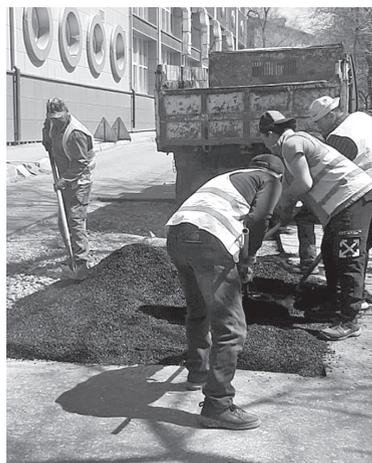
Речь идет об участках, где в прошлом году ремонтировали сети, но не успели завершить благоустройство. Технологически, из-за минусовых температур, невозможно было проводить асфальтирование сразу после ремонта, поэтому участки временно засыпали щебнем с последующим
