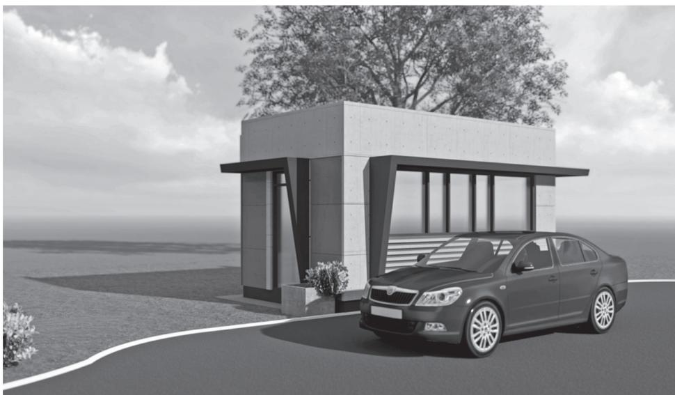
Конструктивное решение киоска – металлоконструкции с заполнением сэндвич-панелями и последующей отделкой фасадов фиброцементными панелями, деревянной обрешеткой, алюкобондом.
