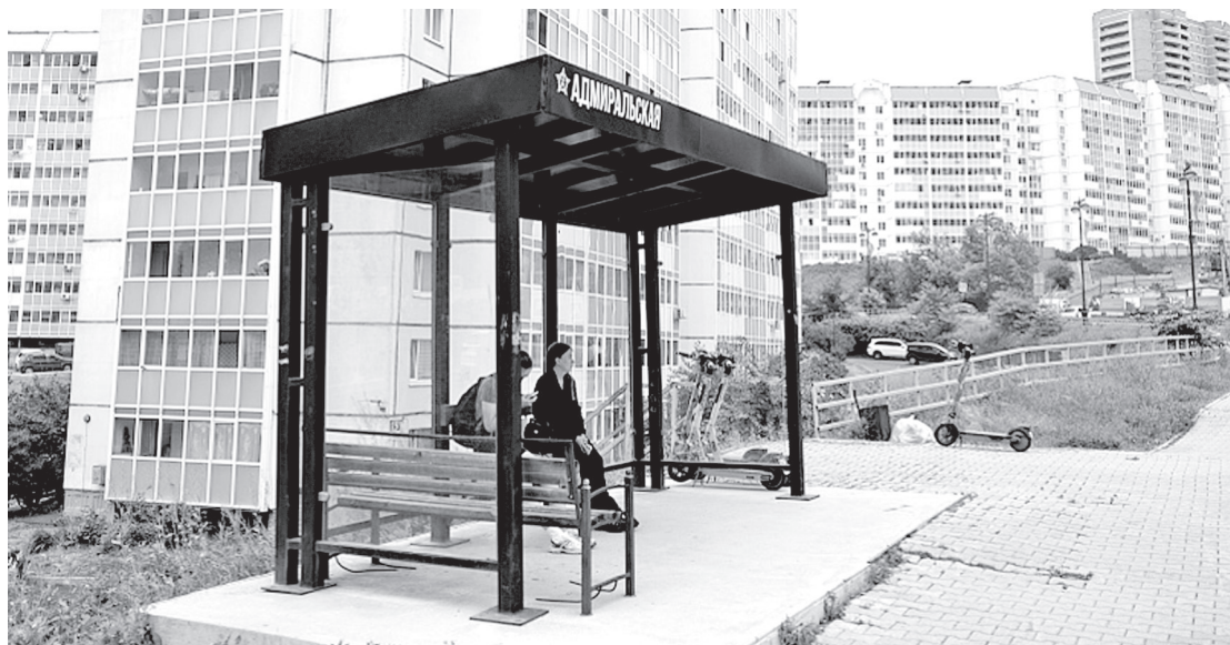
Во Владивостоке завершаются работы по ремонту остановочных павильонов
