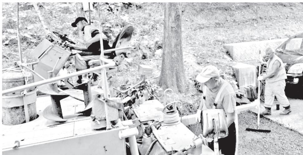
На улице Котельникова, в районе дома № 2, завершен комплексный ремонт проезда. Здесь уложили 43 метра нового вибропрессованного бордюра с бетонным основанием, отсыпали щебень и уложили 105 тонн свежего асфальта.
